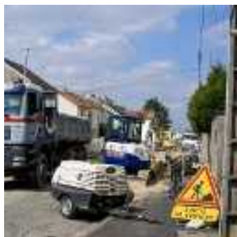
D'importants travaux sur une petite section de la rue.
